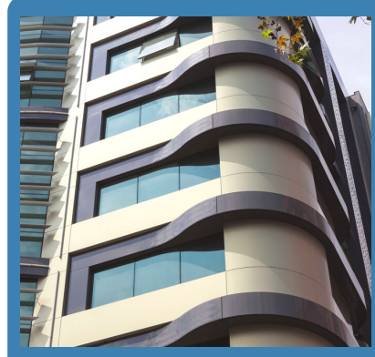
Kompozit Panel Uygulama
